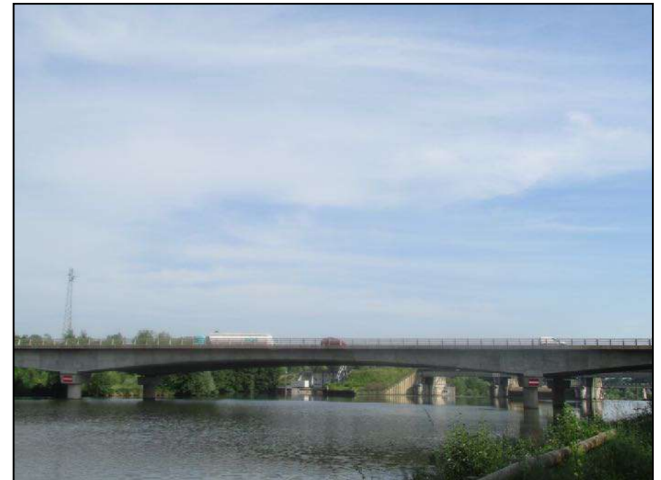
le pont de l'A 31 enjambe la Moselle canalisée
