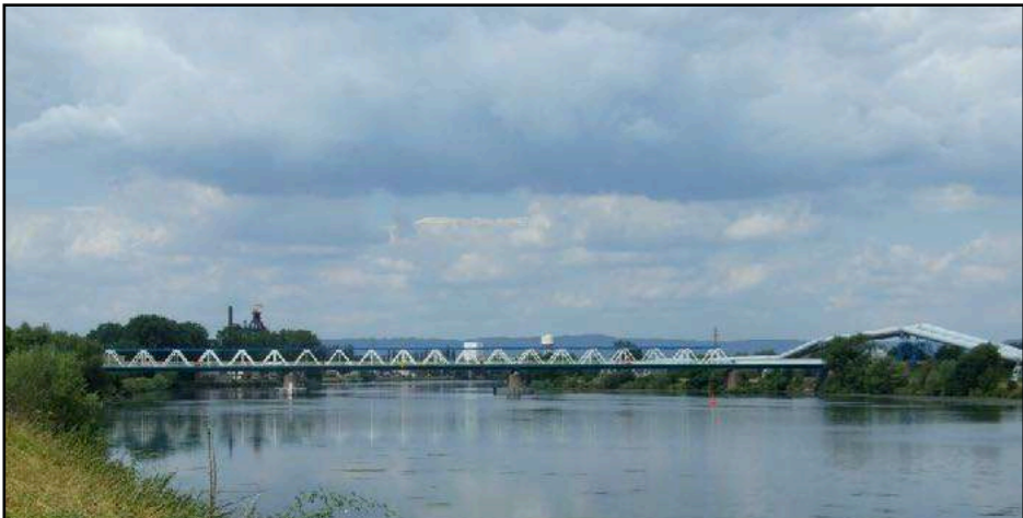
pont construit en 1947, selon des plans allemands. En Novembre 1944, les américains franchissent la Moselle à cet endroit (opération Casanova)
