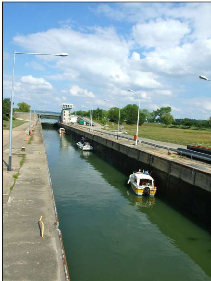
l'écluse de Koenigsmacker, mise en service en 1964
