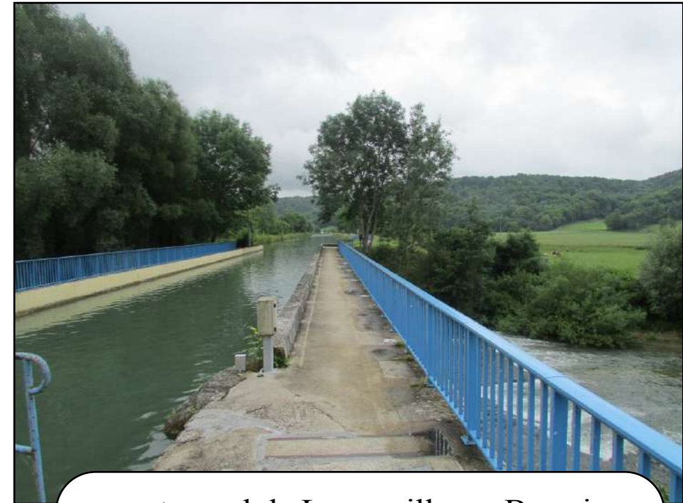
pont-canal de Longeville-en-Barrois, avec l'Ornain en contre-bas
