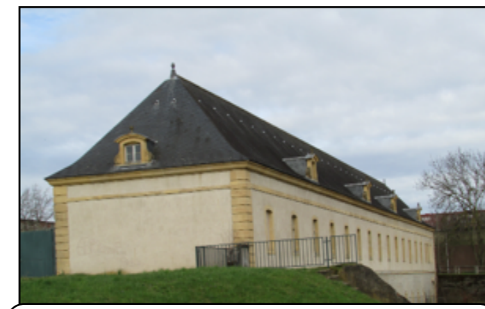
fin de la Véloroute en Moselle
