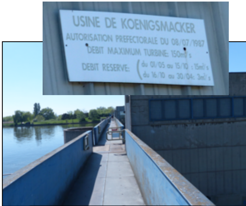
on traverse à pied un ouvrage sur la Moselle
