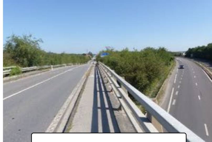
on enjambe l'autoroute
