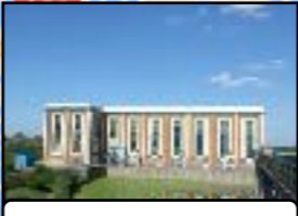
Argancy centrale electrique
