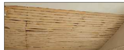
Lattis au plafond
