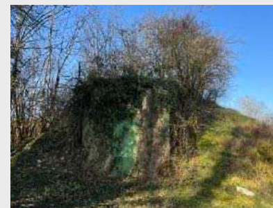
Le château d'eau de Luméville
