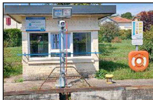
Ecluse n° 22 de Dombasle
