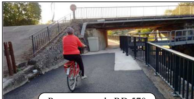
Passage sous la RD 570
