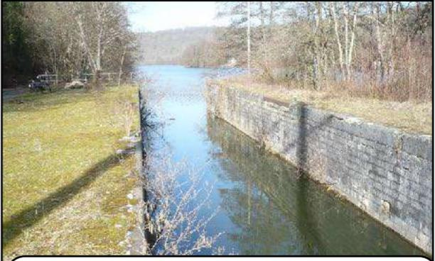
Ancienne écluse N°50 du canal de l'Est, aujourd'hui déclassé et remplacé par la Moselle canalisée
