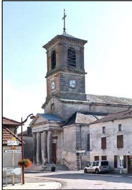
Eglise Saint-Pierre-ès-Liens bâtie en 1841
