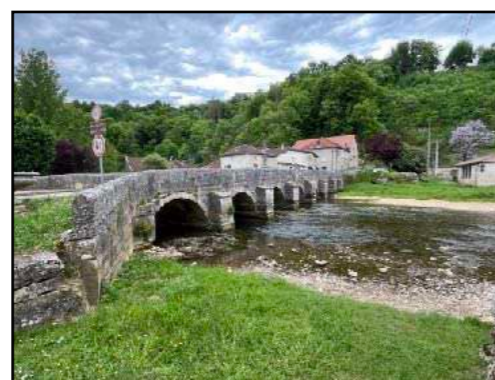
Pont de 1557, lavoir et abri
