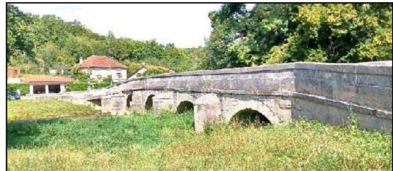
Comme dans de nombreux villages situés sur la Saulx, Beurey possède un pont de pierre datant probablement de la fin du XVII e S. Il présente six arches en plein cintre et épouse la forme d'un léger dos d'âne. Un calvaire du XIX e me siècle a été installé sur le côté amont du pont. Une aire de jeux et de pique-nique est aménagée de l'autre côté du pont
