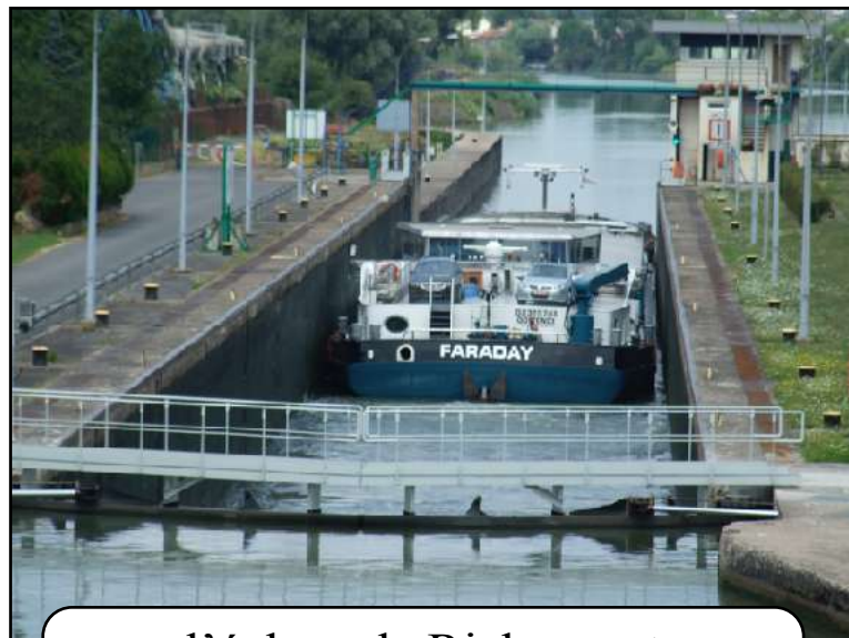
l'écluse de Richemont
