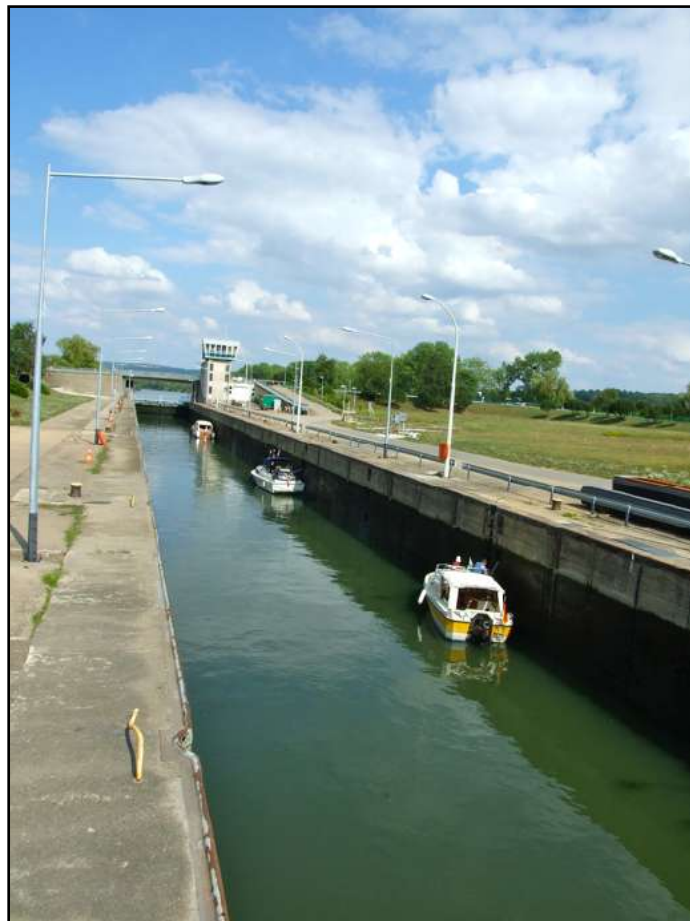
l'écluse de Koenigsmacker, mise en service en 1964
