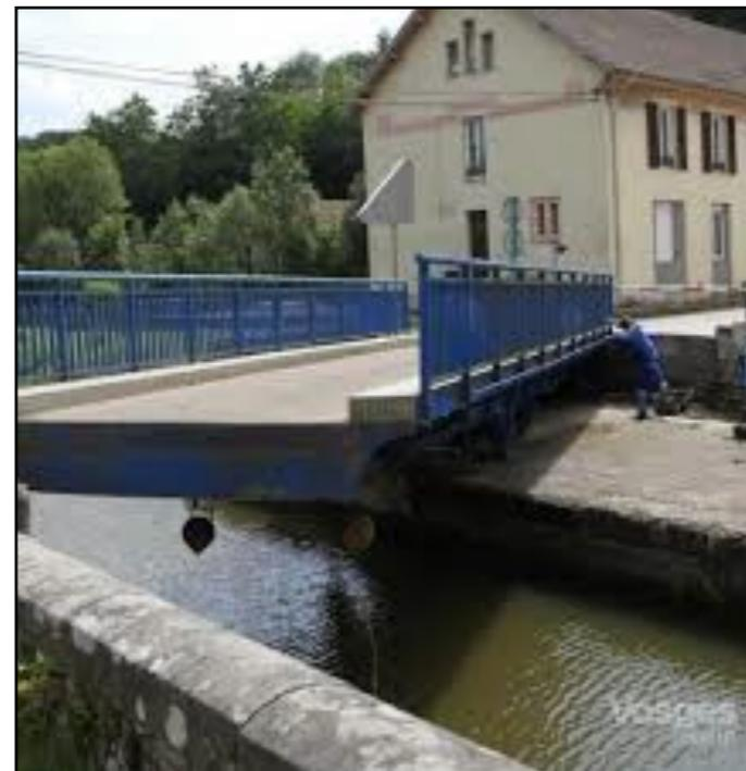
ce pont-tournant a été réalisé en 1880 pendant la construction du canal de l'Est. Il est toujours en fonctionnement, mais il limite la taille des bateaux naviguant sur le canal. Ci-contre le pont de Selles, entre Fontenoy-le-Château et Corre.
